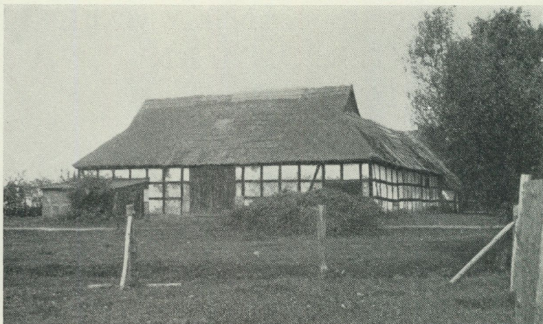
Bild 1. Fyrkantgård i Fritzow, Kreis Cammin. Mittlänga en lada av saxisk typ och lägre sidolängor. Mitt emot ladan ligger ett saxiskt tvärhus som boningslänga.
