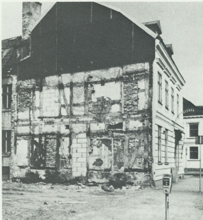
Ett gammalt korsvirkeshus som fått sin gatufasad ersatt av l-stens tegelmur under 1800-talets mitt. Landskrona. Foto förf. 1980.
