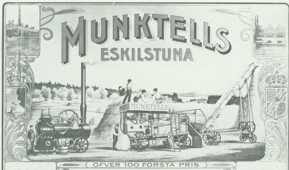
Tröskverk med ångmaskin från Munktelles verkstäder i Eskilstuna. Annonns från omkring 1880. Foto i Nordiska museet.
