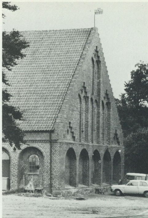
Katedralartad ladugårdsarkitektur förekommer vid många skånska storgods. Ladugården på Jordberga uppfördes 1844 efter ritningar av C G Brunius. Foto förf. 1982.
