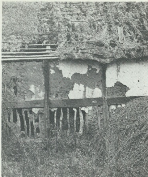
Det förindustriella Skånes bebyggelse var i stor utsträckning av snabbt förgängligt korsvirke med risflätning och lerklining. Hyby sn, Skåne. Foto i Nordiska museet.
