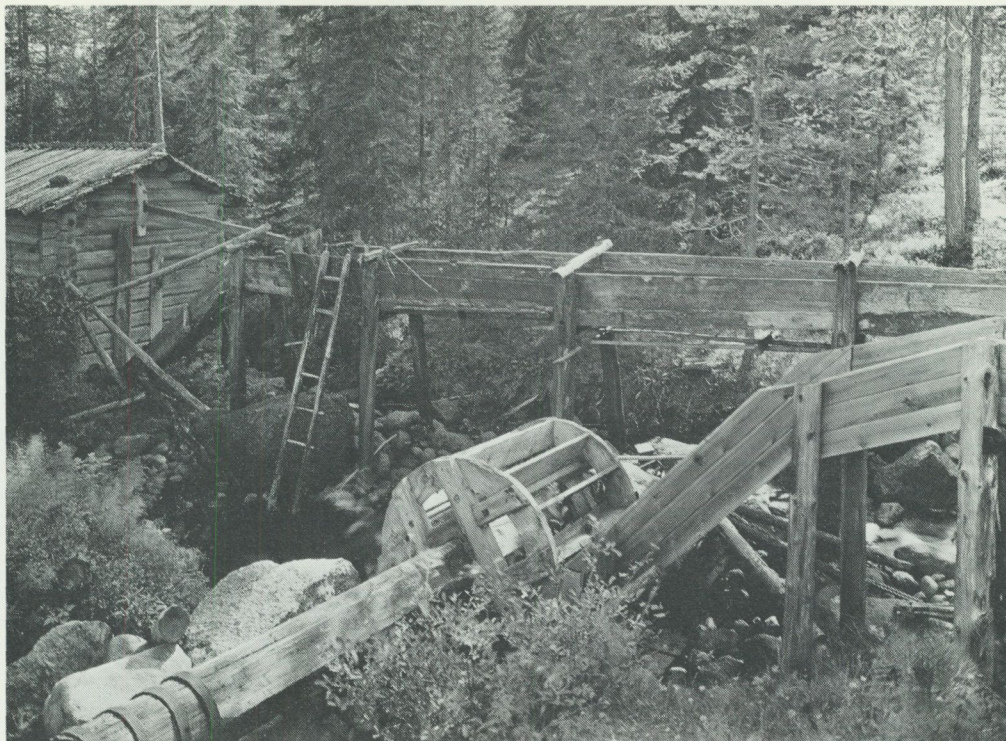
Skvaltkvarn och spånhyvel, Bjursås sn, Dalarna. Av borte vattenrännan framgår att spånhyveln drivs av ett underfallshjul av ungefär samma utseende som hjulet i bildens förgrund som driver kvarnen. Notera att vattenstämnet regleras via en stångmekanism inifrån hyvelhuset. Foto 1926, i Nordiska museet.
