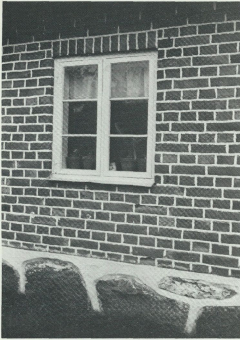
Tegel var en nymodighet som stombildande material i småsamhällellenas nybebyggelse vid 1800-talets mitt. Här ett exempel från en gammal fiskarbostad, byggd i en våning. Vitemölla. Foto förf. 1982.
