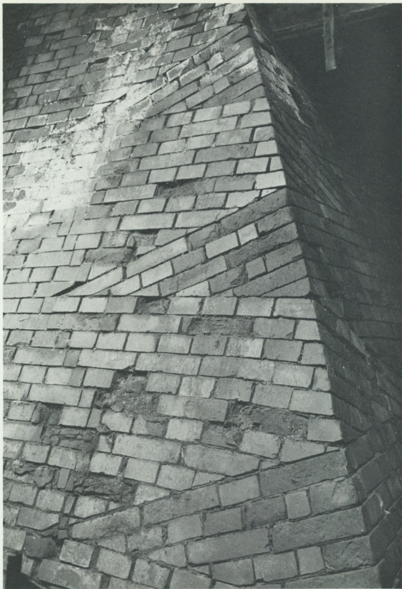
Ugns kroppens murverk fick ofta en rent bastionsartad utformning för att motverka förskjutningar i konstruktionen vid stark uppvärmning. Yddinge tegelbruk. Foto förf. 1982.
