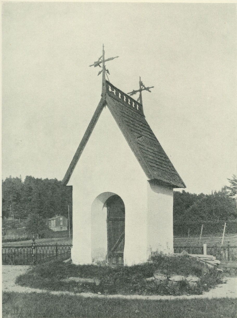
Bild 12. Stiglucka med spåntak och genombruten takkam. Byggnaden är medeltida men takbeklädnad från nyare tid. Kammen rekonstruerad i medeltida form före modern tid. Högs kyrka, Hälsingland. Foto H. Cornell.
