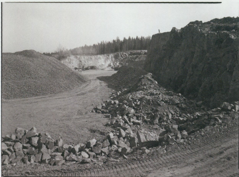
Klevshult i april 1994. Berg förvandlas till fyllnadsmassor.
