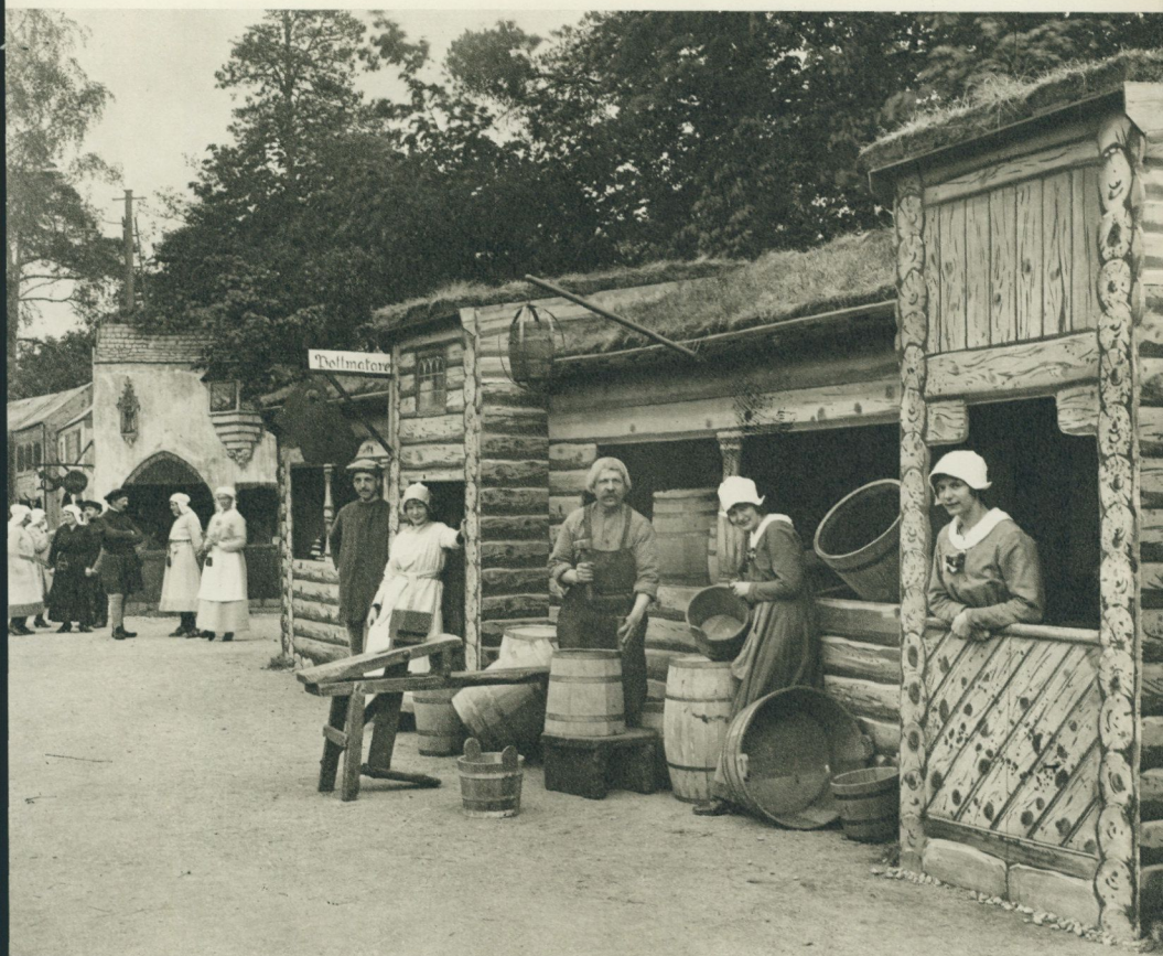
Gatubild från Skråtuna med tunnbindareverkstad.
