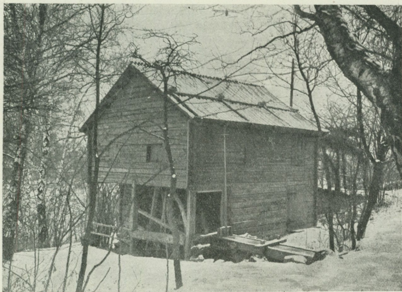
Fig. 2. Skansens linberedningsverk. Exteriör. I förgrunden vattenhjulet och rännan med stämbolsluckan, vilken genom en stång är förbunden med en »arm», sträckande sig ut genom väggen tätt under takfoten. I väggarna fyra »luckhål» och en »port» (dörr).
