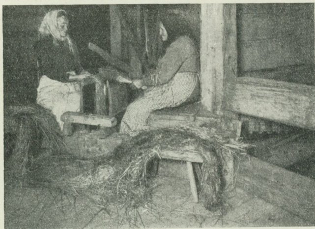
Fig. 10. Två kvinnor skäktande lin. På stolar, vid sidan om kvinnorna, ligga bruggade (och korslagda) lindhällor, färdiga att läggas under svarmen. Hällorna placeras över skaffötterna, såsom bilden visar. T. h. nedtill syns en liten del av drivhjulet.
