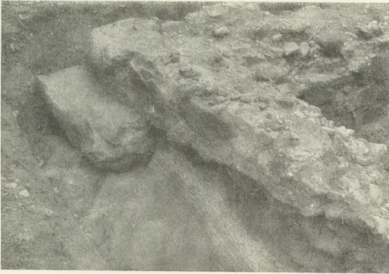
Bild 8—9. Från utgrävningen. 8. Trappan från sydväst. 9. Utsidan av stengrundens sydöstra hörn från Ö. Den kraftiga hörnstenen vilar på berget. Bilden visar tydligt, att den varviga leran fortsätter in under muren, som dock på insidan (åt källaren till) ligger direkt på berget.
