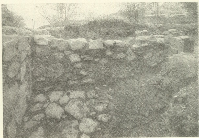
Bild 6—7. Från utgrävningen. Bilderna avse att åskådliggöra skillnaden i byggnadssätt mellan yttermurar och innermurar. Exempler hämtade från västra vinkeln mellan norra långmuren (6) och stora, tvärgående innermuren (7).
