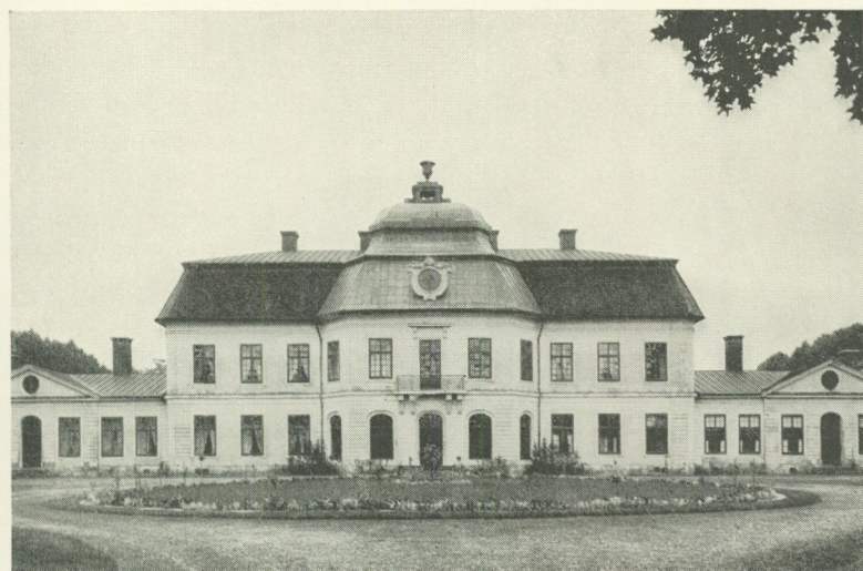
Bild 2. Österby, gårdsfasaden. Takets ursprungl. utseende återfinnes å bild 3.
